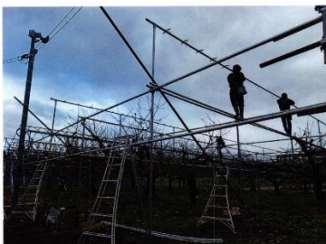
棟パイプ設置状況
