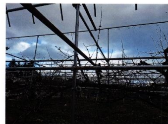
アーチ設置状況
