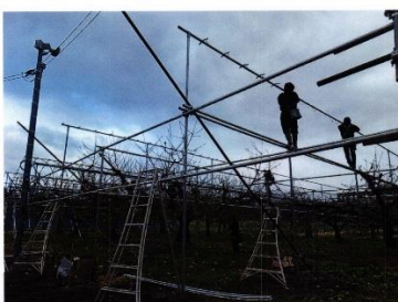
棟パイプ設置状況
