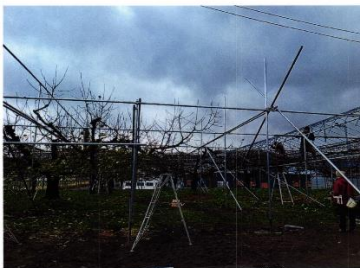
筋交い設置状況
