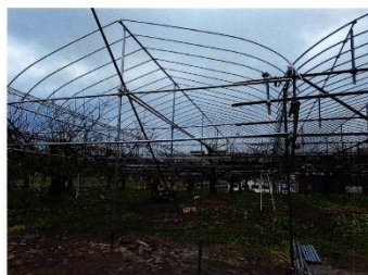
アーチ設置状況
