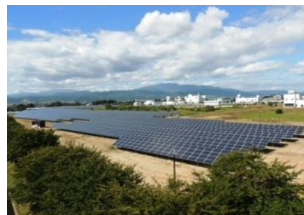
山形浄化センター
