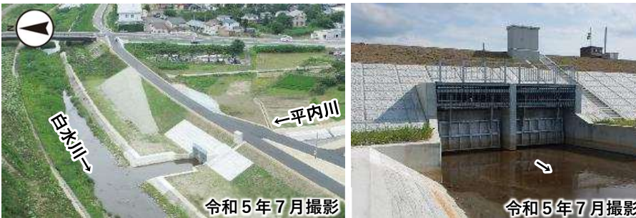
平内川排水樋門整備状況
