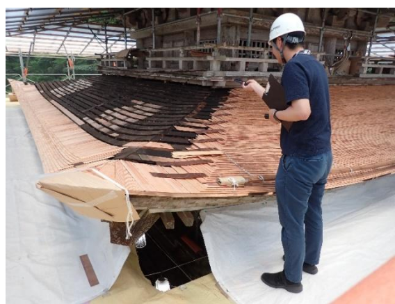
(柿葺き屋根の葺き替え)
