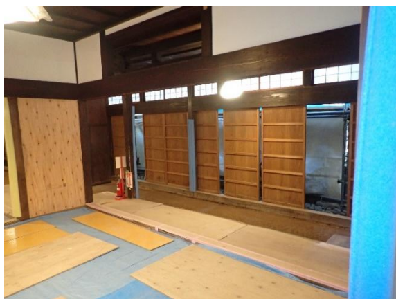
(建物の耐震補強)
