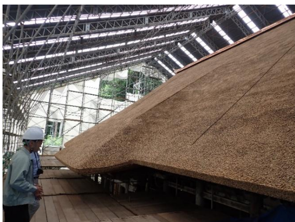
(茅葺き屋根の葺き替え)
