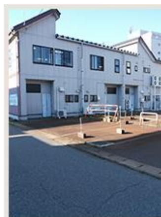
建物裏側 駐車場 (1台分)
